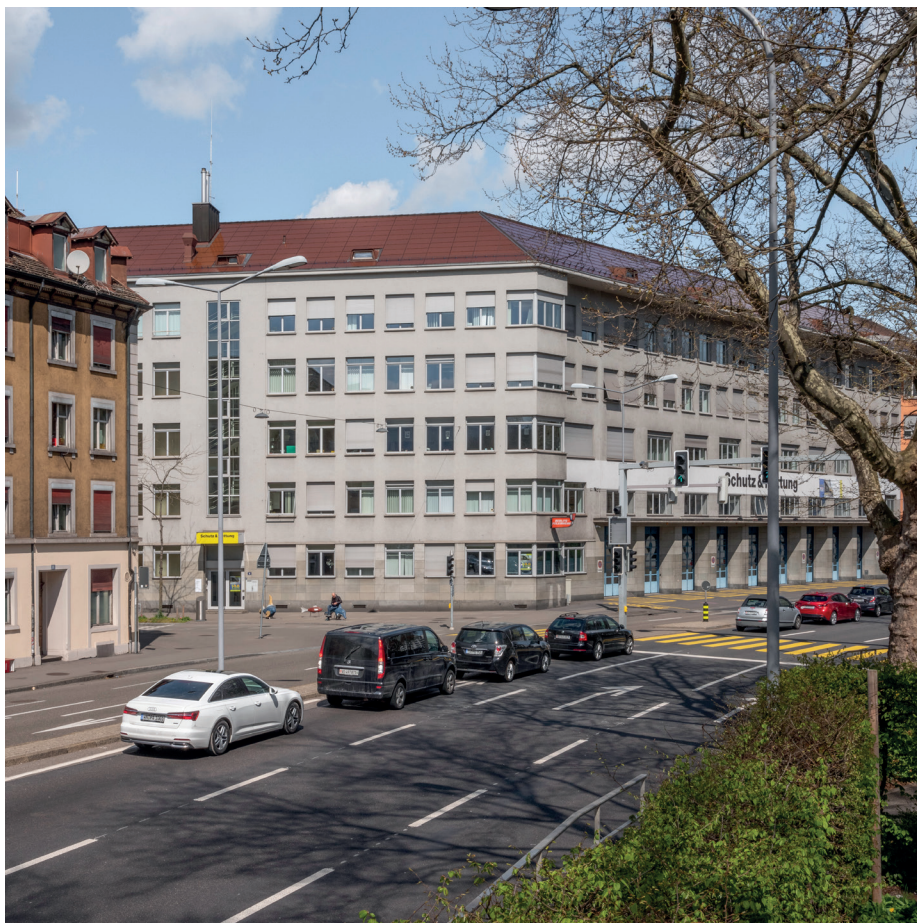
Ristrutturazione del tetto, Edificio «Schutz und Rettung», Zurigo (foto: Pierre Marmy, Patrimonio svizzero)
